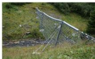
Barreras flexibles contra debris Flow / deslizamiento superficial
