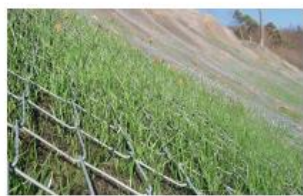
Estabilización de taludes
